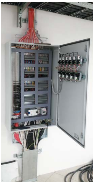
РИС. 1. ► Шкаф диспетчеризации ЦОД с использованием компонентов WAGO
